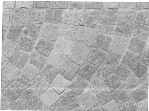
Esempio pavimentazione in Luserna
